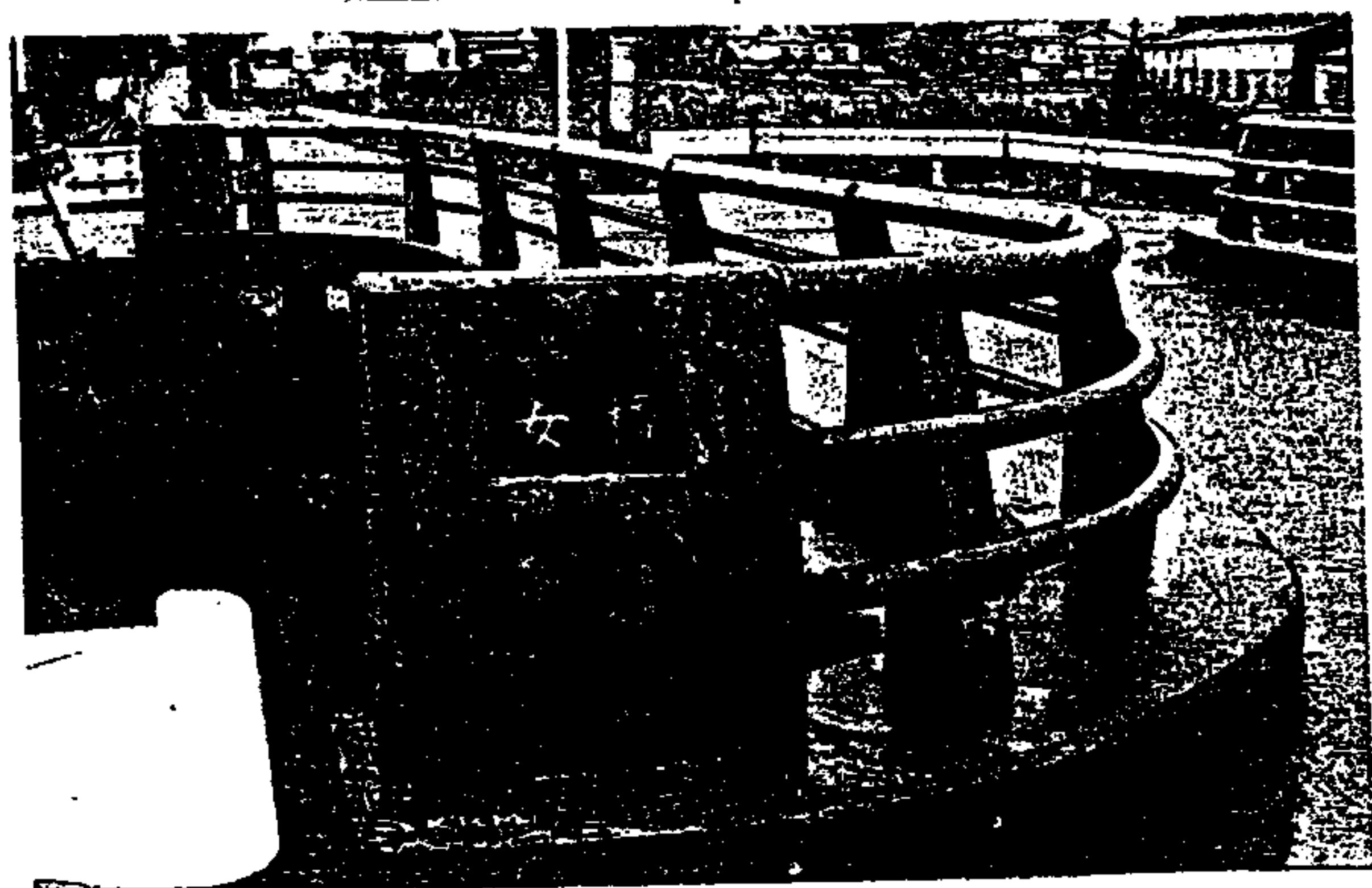
二ツ橋の女橋
